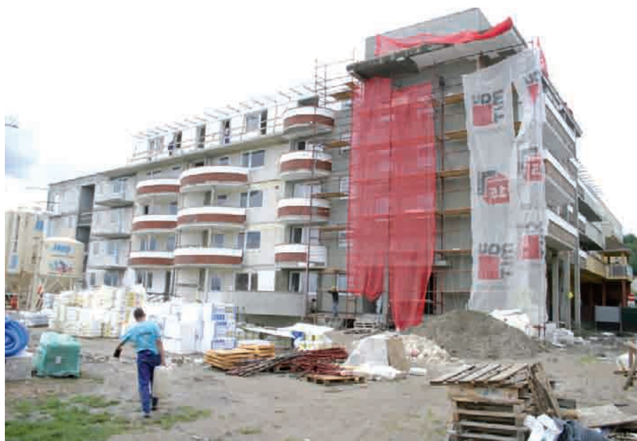
W budynku mieszkalnym w Redzie, który od 9 lat niszczał, trwają prace budowlane
