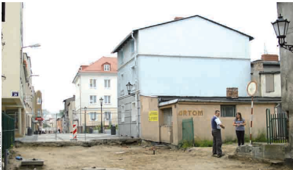
Niektóre budynki przy ul. Wałowej mają być wyburzone, inne pozostaną
