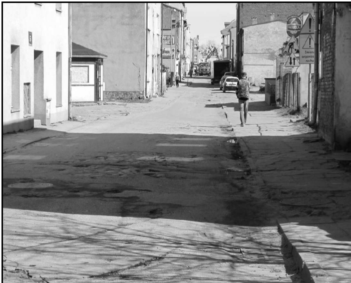
Tak wyglądała ul. Wałowa przed remontem — wrzesień 2010 r.
